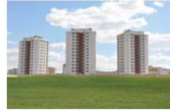
ELMASLAR DOĞAPARK BAĞLICA
